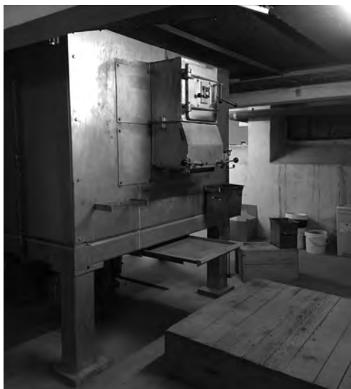
FIG. 6 PARTIE BASSE DU FOUR CRÉMATOIRE
