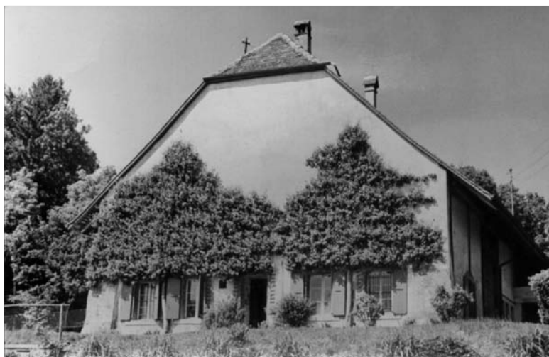
La Canebière, l'ancienne ferme attenante au centre médico-pédagogique du Châtelard à Vennessur-Lausanne qui fut le premier lieu occupé par le Centre de formation d'éducateurs pour l'enfance inadaptée de 1954 à 1956. (Photo Gilbert Kramer)
